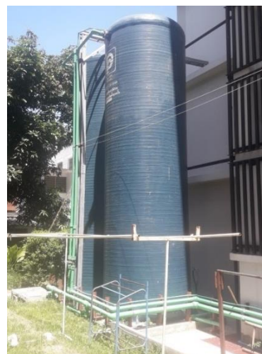
รูปที่ 2. 111 ตัวอย่างถังเก็บน้ำฝน 5,000 ลิตร จำนวน 1 ถัง (หอ 55 ปี พยาบาล)
