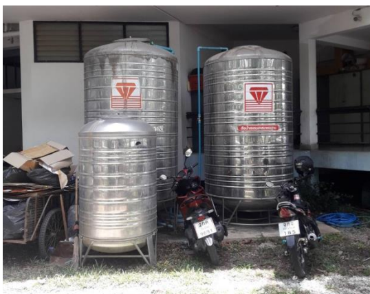
รูปที่ 2. 108 ตัวอย่างถังเก็บน้ำฝน 5,000 ลิตร จำนวน 2 ถัง (หอ ชาย 5)
