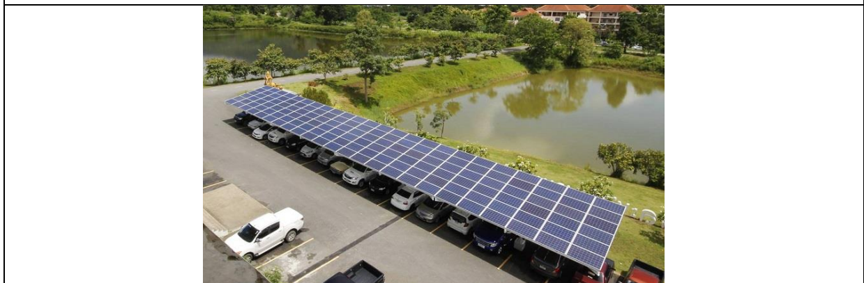
รูปที่ 2. 53 Example of Solar Roof (Energy Research and Development Institute – Nakornping)
