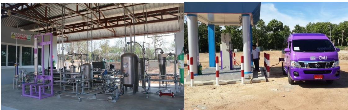
รูปที่ 2. 88 เครื่องคัดแยกขยะ (บน) อุปกรณ์ทดสอบคุณภาพไบโอแก๊สแต่ละชนิด และสถานีเติม CBG (ล่าง)
