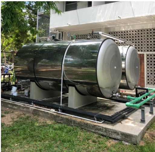
รูปที่ 2. 108 ตัวอย่างถังเก็บน้ำฝน 5,000 ลิตร จำนวน 2 ถัง (หอ ชาย 5)
