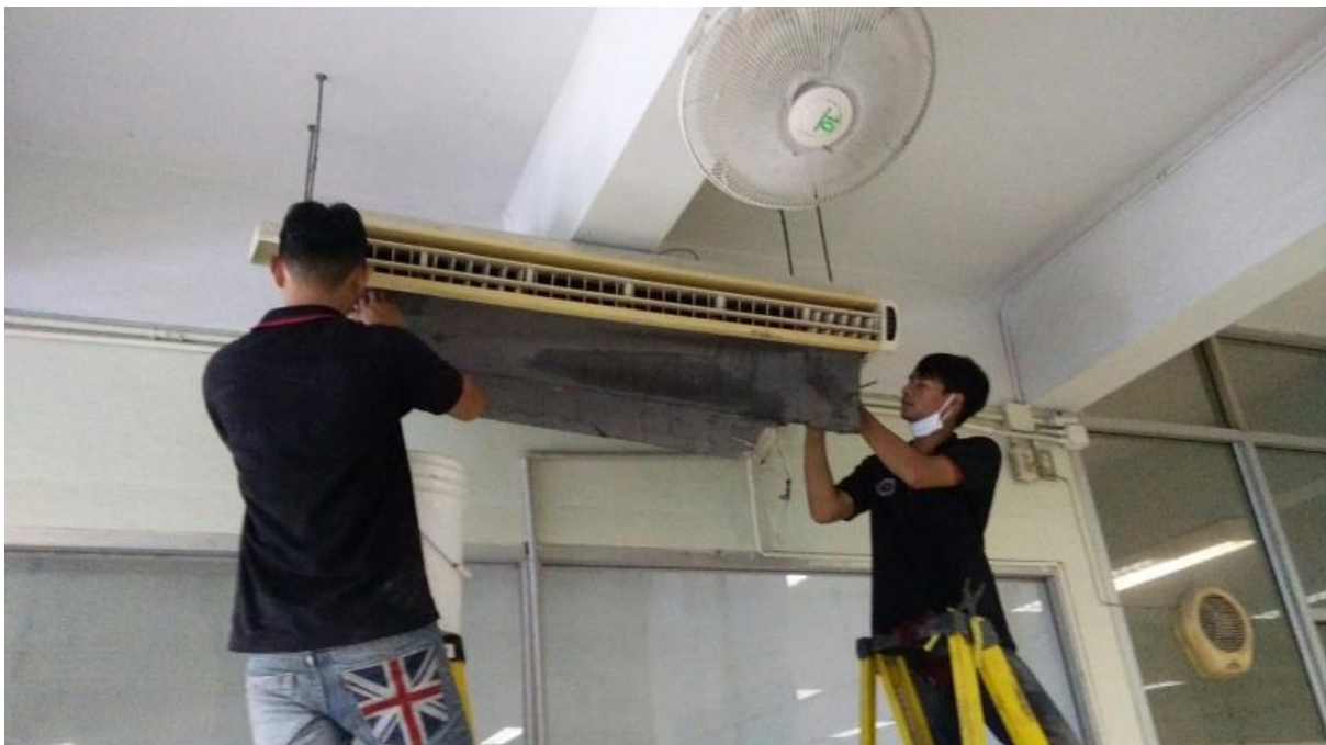
รูปที่ 2. 33 การล้างแอร์ในอาคารคณะสถาปัตยกรรมศาสตร์ (Source: shot on 15 Feb 2018)
