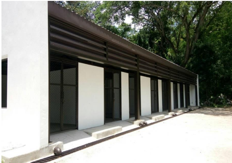
รูปที่ 2. 25 Waste separation station for recycle bank
